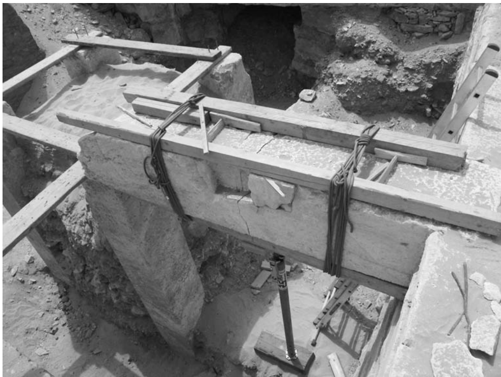
Obr. 5 Architráv po slepení a provizorním zajištění (foto M. Dvořák)
