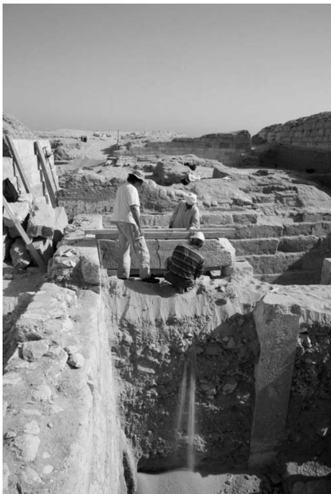
Obr. 3 Přípravné práce před lepením poškozeného architrávu (foto H. Vymazalová)
