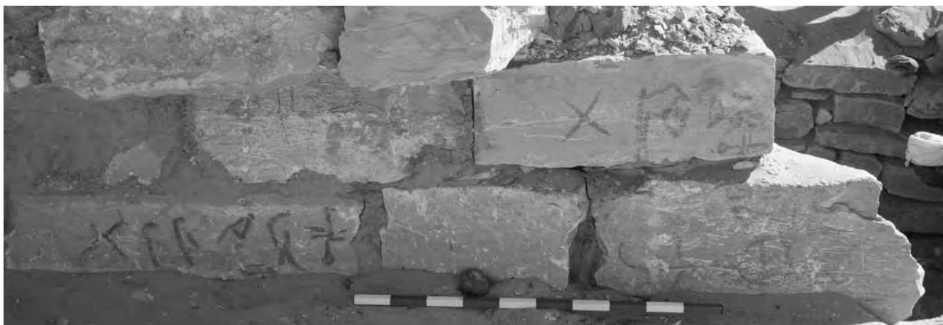
Obr. 4 Hieratické nápisy zanechané staviteli uvádějí jméno a titul majitele hrobky lymeriho. Nápisy v pravé části snímku jsou otočeny naležato, což potvrzuje, že byly zapsány před tím, než se kamenné bloky uložily do hrobky (foto F. Coppens)
